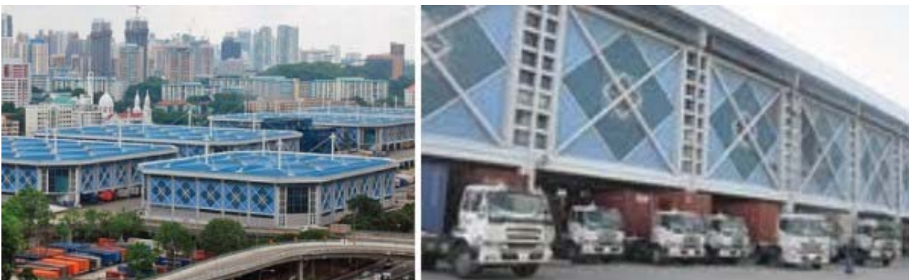
Рис. 8. Keppel Distripark, Сингапур. (Источник: http://www.singaporepsa.com/ )
