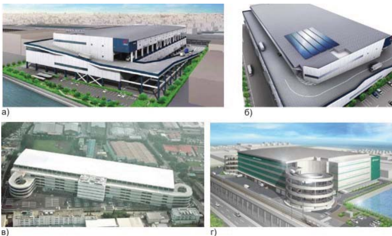
Рис. 13. Примеры многоуровневых складов с пандусами: а,б) Chidori-cho Logistics Center, Итикава (Япония), 2001г.; в) Logi Port Kashiwa, Токио (Япония); г) Ichikawa Logistics Center II, Итикава (Япония), 2008г.
