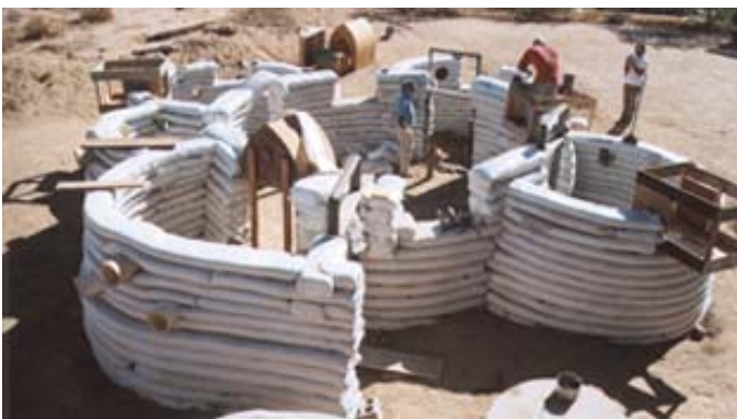
Рис. 19. Проект «Жилье из мешков с песком». Типовая модель, реализованная на практике в разных местах. Арх. Н. Халили. Источник: http://www.akdn.org
