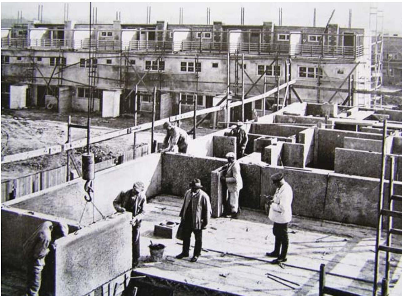
Рис. 11. Монтаж домов из крупных пемзобетонных плит. (Источник: Современное строительство Германии. Первая заграничная экскурсия инженеров-строителей и архитекторов. М.: Гостехиздат, 1929. 224 с.)
