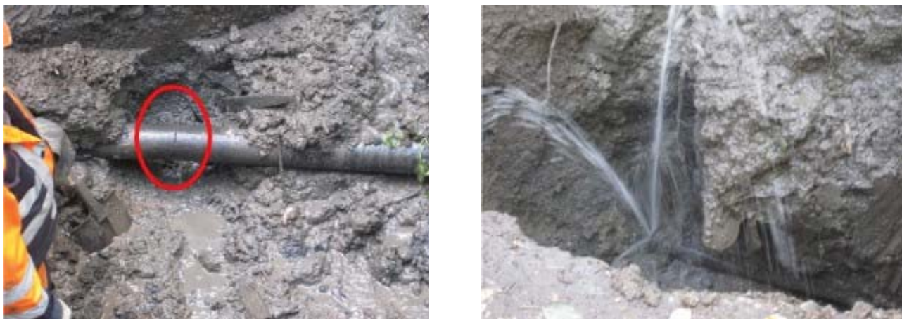
Рис. 7. Неоднородность грунтов активного слоя земной коры в Екатеринбурге Авария на ул. Белореченская, 24 в августе 2010 г. ( Фото Осиповой А.Ю)
