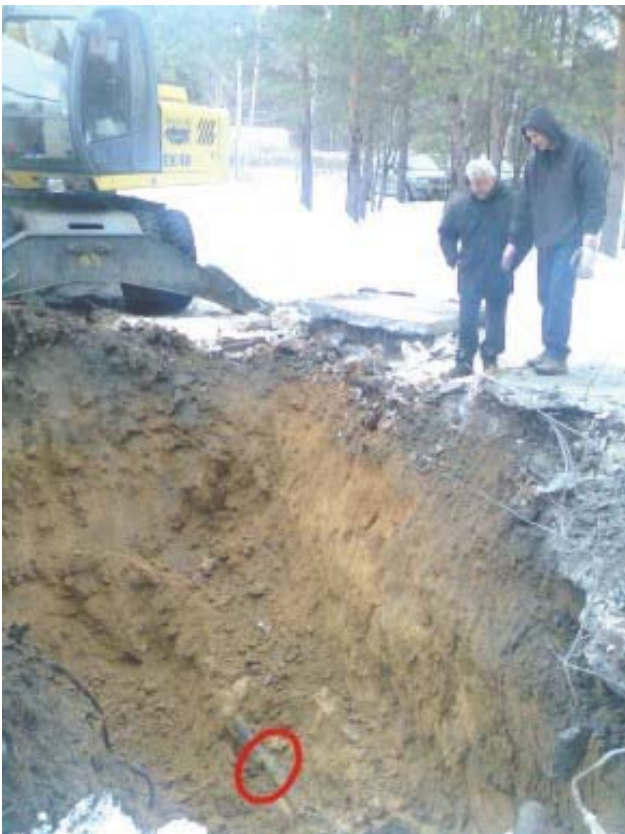
Рис.17. Авария на городском водопровode на ул. Амундсена, 100 в г. Екатеринбурге возле крыльца Института геофизики УрО РАН в ноябре 2009 г. Фото Осипова В.Ю., 2009 г. Чугунная труба диаметром 100 мм, проложенная в элювиальных суглинках по габбро, разорвана поперечной трещиной, по которой произошло смещение участков трубы.
