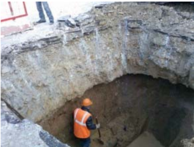
Рис. 16. Пример воздействия грунтов активного слоя земной коры на трубы городского водопровода, обусловленного сезонными изменениями объема и физико-механических свойств морозопучинистых грунтов. Авария на перекрестке ул. Амундсена и Краснолесья в январе 2010 года. (Фото Осиповой А.Ю.) Чугунная труба диаметром 300 мм сломана по причудливой траектории. Коренные породы, представленные габбро, вмещающими тело гранитоидов, залегают на глубине около 2,5-3,0 м. Возможно, что промороженные сверху грунты (на верхнем фото светлые образования в верхней части разреза), увеличив свой объем и ставшие более твердыми прижали трубу к консолидированным скальным породам, что способствовало ее разрушению.
