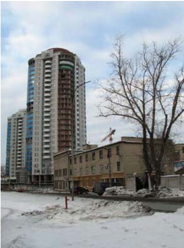
Рис.16. Строящийся жилой комплекс «Аквармарин» на ул. Радищева-Хохрякова, застройщик «Атомстройкомплекс». Фото А.Л. Маргушина, 2005
