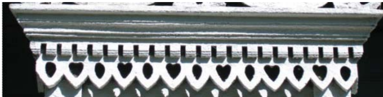
Рис. 8. Знаки воды (дождя) и «груды» в декоре деревянной архитектуры г. Иркутска (ул. Кайская, 22). Фото А. Матвеевой
