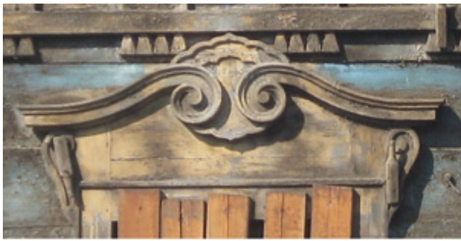
ул. Карла Либкнехта, 31
