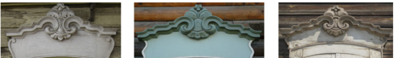
Рис. 13. Примеры наличников пятого типа: ул. Тимирязева, 21, ул. Грязнова, 22, ул. Седова, 13 (фото Н. Зарубиной)
