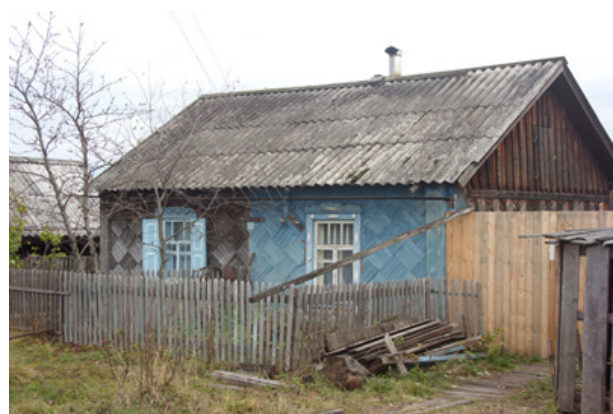
Рис. 4. Спецпереселенческий дом 1931–1932 гг. постройки. Современное состояние. Источник: архив автора
