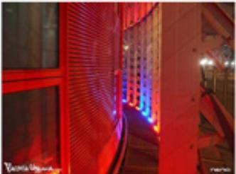
Естественную вентиляцию здания Torre Agbar обеспечивает двойной фасад: Первый слой - плотная бетонная скорлупа, второй - система полупрозрачных стеклянных жалюзи
