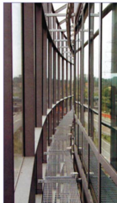
Рис. 8. Принцип вентилирования в двойных фасадах. Источник: <http://www.abok.ru>
