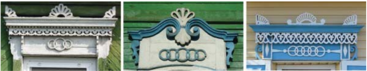
Рис. 17. Кольца и стрелы: ул. Кирпичная, 62; ул. Писарева, 10; ул. Писарева, 11. Фото В. Асманкиной
