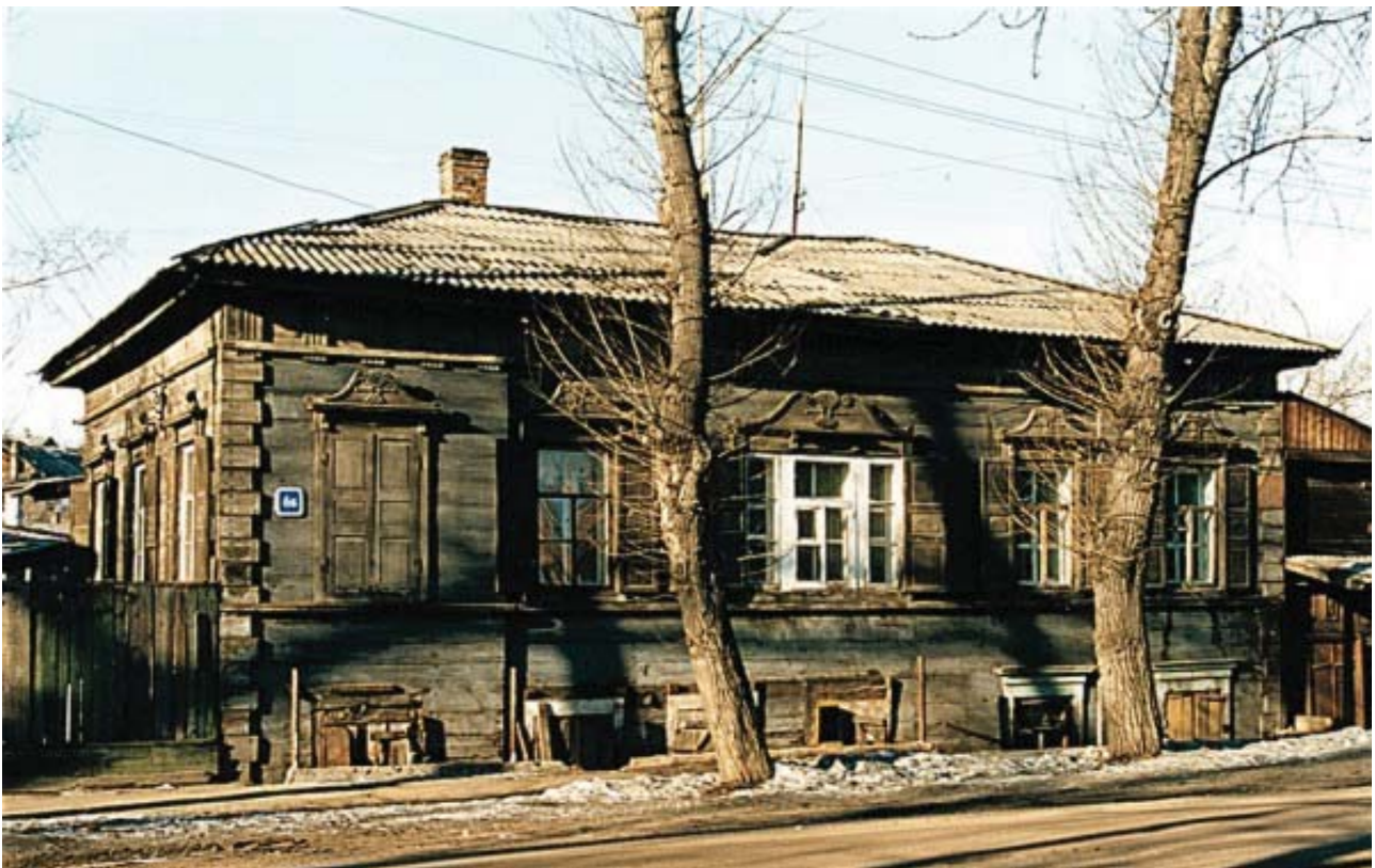
Рис. 5. На деревянных фасадах, так же как и на образцовых – каменных, центральное окно выделялось композиционно: ул. Борцов Революции, 6. Фото И. Бержинского
