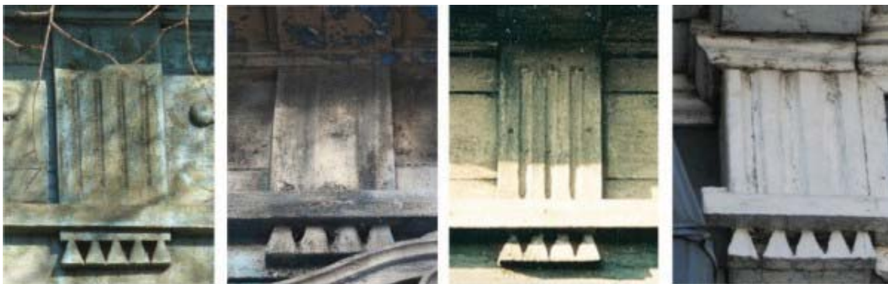
Рис. 14. Декоративное убранство ранних иркутских триглифов: ул. Октябрьской Революции, 11; К. Либкнехта, 31; ул. Борцов Революции, 6; ул. Волконского, 10. Фото. В. Асманкиной
