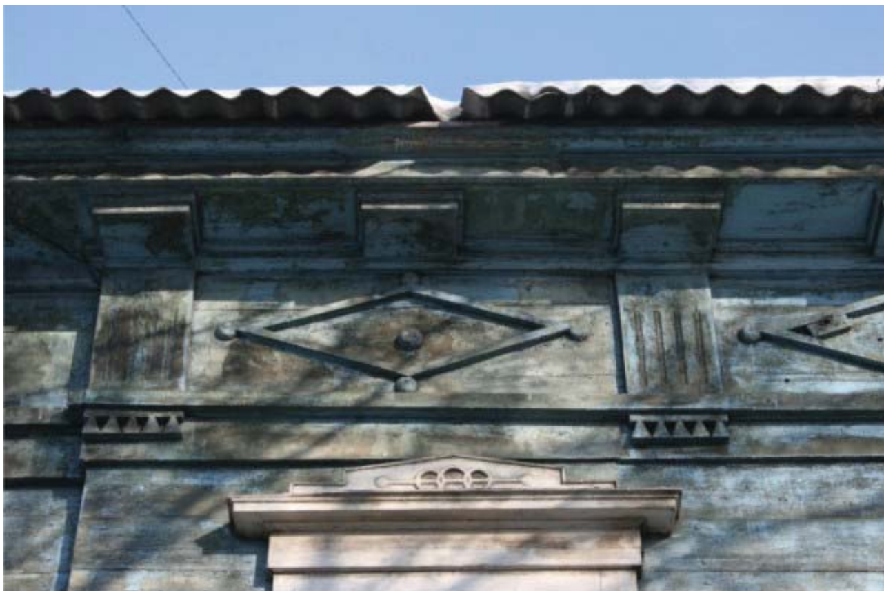
Рис. 12. Заполнение промежутков между триглифами реечными накладками в форме ромба. Ул. Октябрьской Революции, 11. Фото В. Асманкиной
