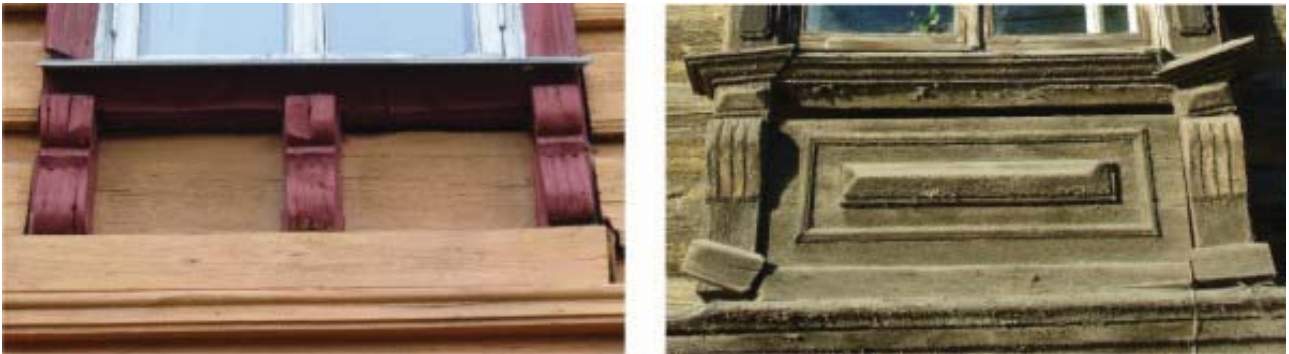
Рис. 33. Кронштейны в качестве подоконного столбика (классический кронштейн): ул. Декабрьских Событий, 56; ул. Гагарина, 8. Фото В. Асманкиной
