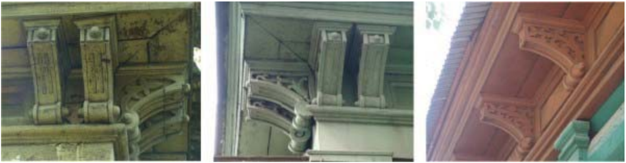
Рис. 31. Кронштейны, декорированные накладными узорами и шишечками: ул. Марата, 54, ул. Декабрьских Событий, 52, ул. К. Либкнехта, 15а. Фото В. Асманкиной
