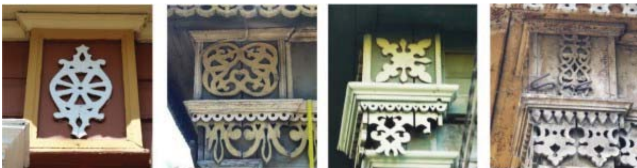
Рис. 21. Триглифы с накладным пропиленным однослойным узором и филенками: ул. Ф. Энгельса, 35; ул. Радищева, 28; пер. Пионерский 1-а; ул. Чехова, 7. Фото В. Асманкиной
