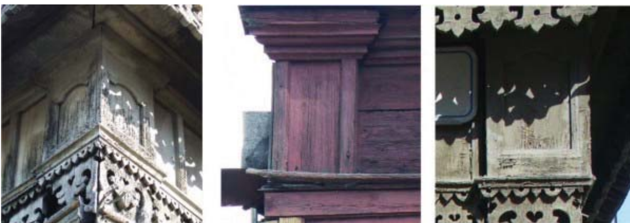
Рис. 18. Триглифы без бороздок с филенками: ул. Марата, 23; ул. Седова, 27; ул. Баррикад, 79. Фото В. Асманкиной
