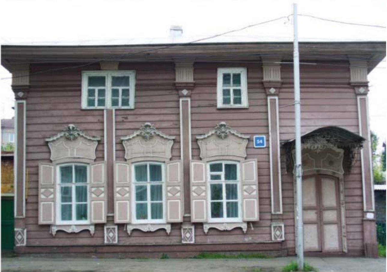
Рис. 7. Триглифы в сочетании с элементами декоративного убранства стиля сибирское барокко: ул. Рабочая, 2; ул. Дзержинского, 54. Фото В. Асманкиной
