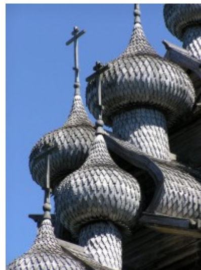
Рис. 17. Традиционный русский гонт на куполах церкви. О. Кижи. Источник: http://photo.qip.ru/users/y-sneg/2231275/38356679/
