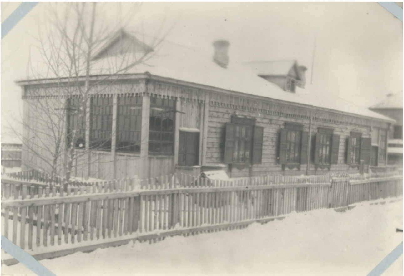
Рис. 6. 2-х квартирный жилой брусчатый дом в г. Прокопьевске, фотография 1949 г. Источник: ГАРФ. Ф. А-150. Оп. 3. Д. 51. Л.8.
