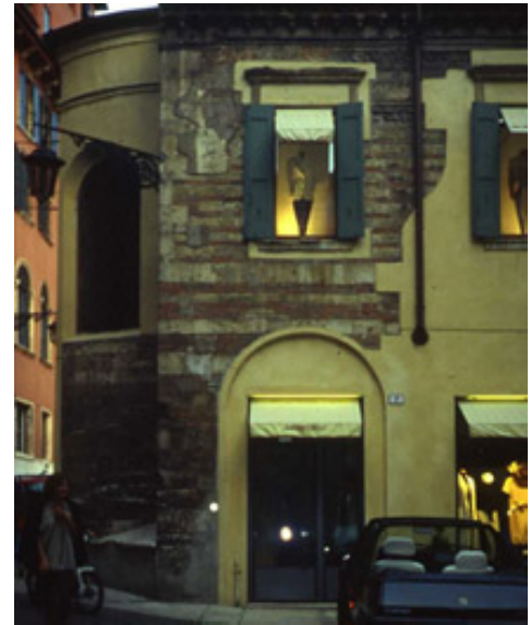
Рис. 8. Экспозиционный зондаж на фасаде здания выявляет раннесредневековую кладку. Верона, Италия. Фото Д. Шатилова, 1995
