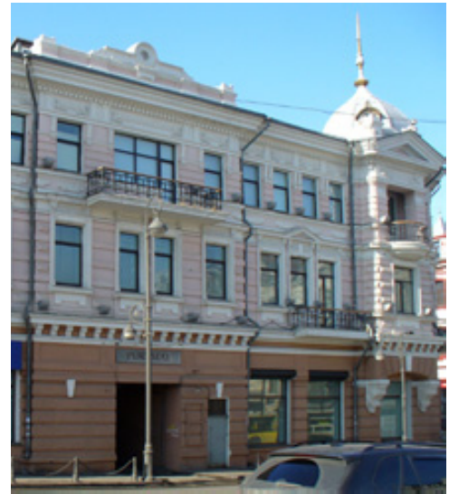
Рис.8. Доходный дом Бабинцева. Фрагмент фасада со стороны ул. Алеутской. Фото автора
