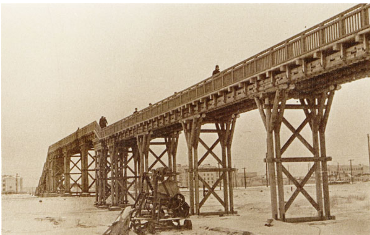
Рис. 2. Новосибирск. Виадук через пути ст. Ельцовка между соцгородом и заводом № 153 им. В.П. Чкалова. Построен в 1943 г. Строительно-монтажным трестом № 7 Наркомата авиационной промышленности. Фото 1940-х гг. Источник: Государственный архив Новосибирской области (ГАО). Ф.П-11796. Оп. 1. Д. 47. Л. 16 (фото 2)
