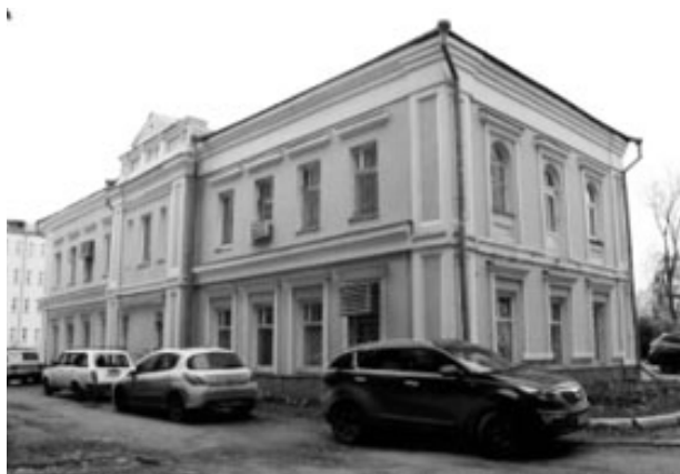
Рис. 11. Заводская амбулатория (1870)Источник: http://qirme.org/ru/
