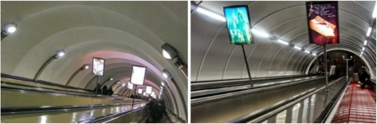
Рис. 17. Наклонный ход эскалаторного тоннеля станции «Лиговский проспект» до и после капитального ремонта. Фото 2012, 2014
