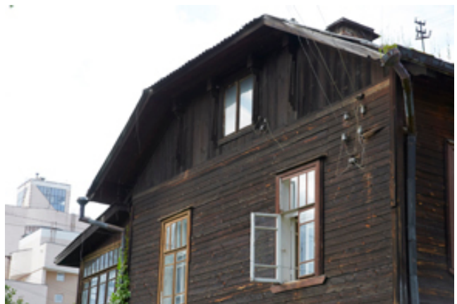
Рис.15. Дом на ул. Декабристов 69г. Конструкции вальмовой кровли с декоративными кронштейнами и окна с оригинальными переплетами сохранились в южной части дома. Фото В.Н. Куршаковой
