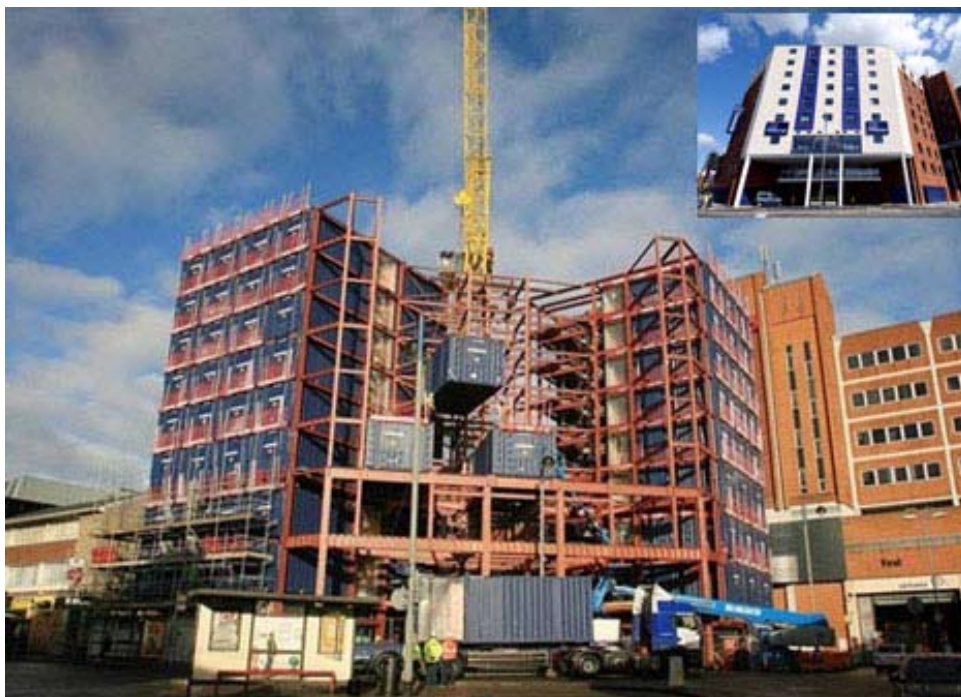
Рис. 9. Модульные многоэтажные гостиницы. Лондон. Источник: http://weburbanist.com/wp-content/uploads/2008/11/14-camouflage-cargo-container-hotel-building1.jpg
