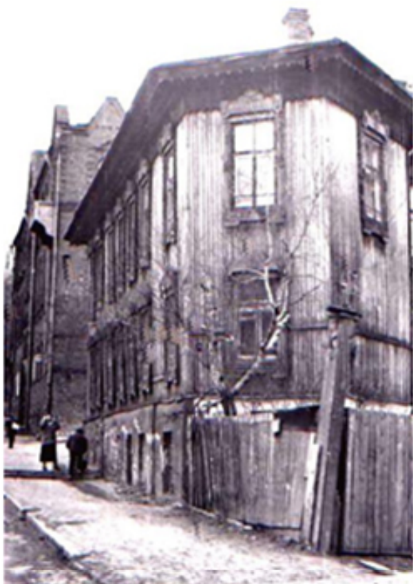
Рис. 1. Томск. Здание бывшего родильного дома на ул. Большой Подгорной, 15. 1896. Фото: А.П. Герасимов, 1996
