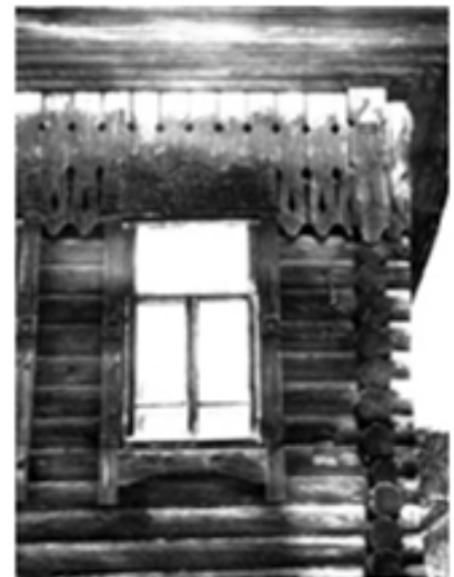
в) фрагмент 2-го этажа
