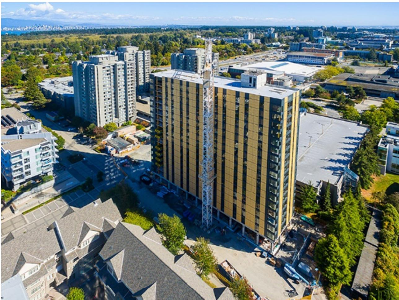
Рис. 5. 18-этажное деревянное здание общежития в Ванкувере, возведенное из CLT панелей.
