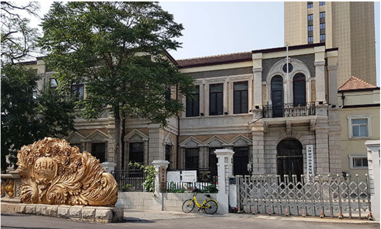
Рис.12. Бывшее здание Русского консульства в Тяньцзине. Вид со стороны ул. 11th Longitude. Фото: М.Е. Базилевич
