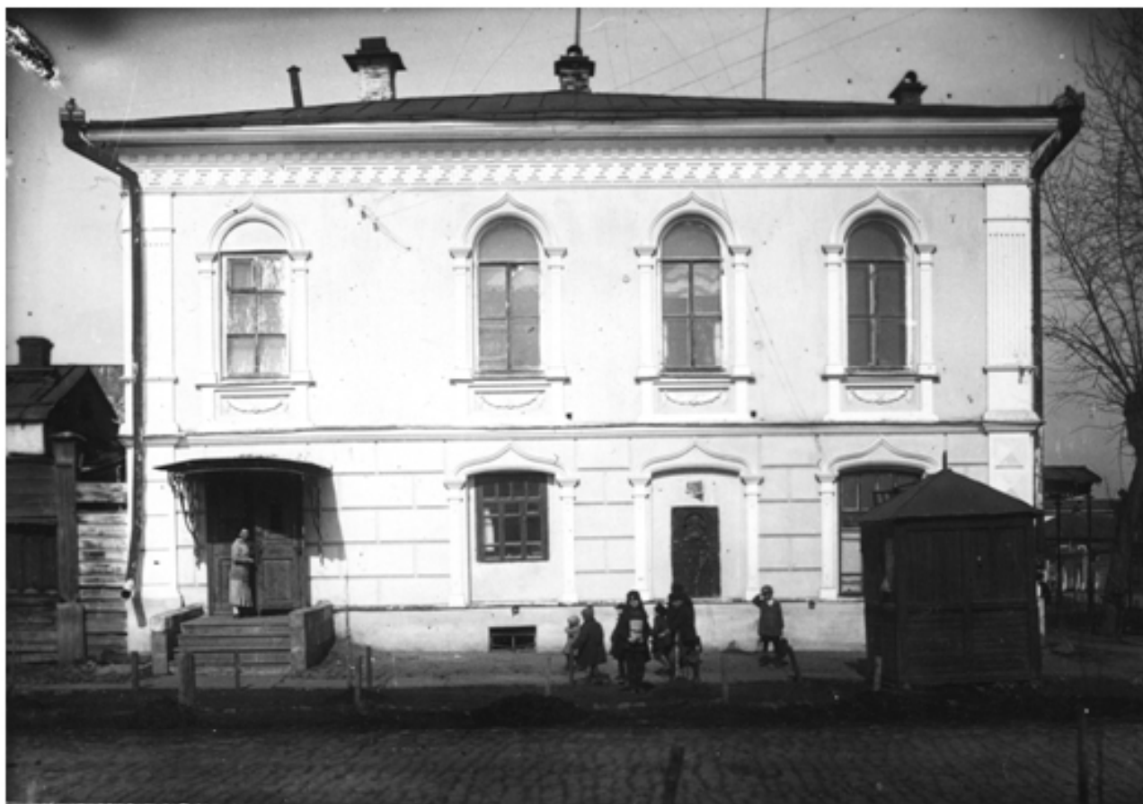
Рис. 3. Фасад со стороны ул. Карла Маркса (фото первой половины XX века)
