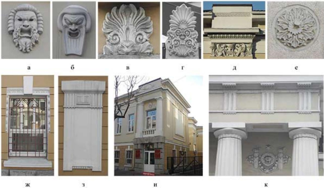
Рис. 4. Декоративные элементы фасада бывшего японского консульства: а, б – маскароны; в – пальметта; г – акротерий (в виде пальметт); д – барельеф с грифонами, орнамент меандр, ионики; е – розетка; ж – окно первого этажа; з – плоскость фальш-окна; и – фрагмент фасада (колонны дорического ордера, объединенные балюстрадой, картуш), к – фрагмент фасада (триглифы, гутты, мутул, картуш). Фото А.А. Толкачевой
