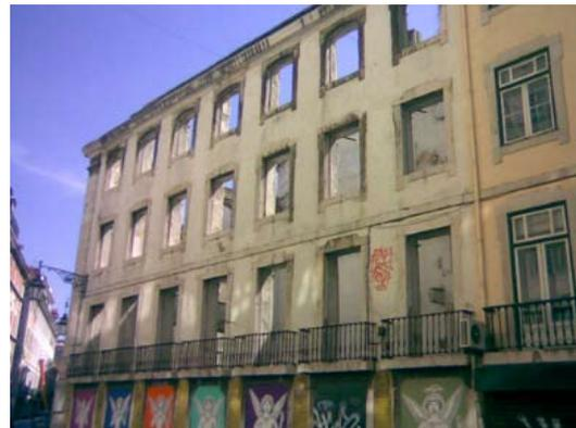
Рис. 22. Здание Помбалино на этапе реставрации. Структура здания полностью разрушена, сохранён только фасад, к которому будет пристроена железобетонная конструкция нового здания. Фото С. Морайш
