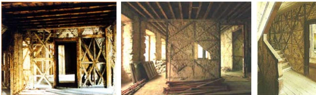
Рис. 13. При реконструкции зданий Помбалино открывается структура деревянной прошивки и крестообразных деревянных элементов. Фото С. Морайш. 2010
