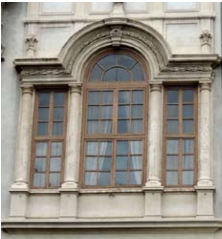
Рис. 9. Окно «серлиана» фасада Палаццо Памфили на площади Навона в Риме. 1644–1650. Архитекторы Дж. Райнальди и Ф. Борромини. Фото В. Г. Власова. 2015
