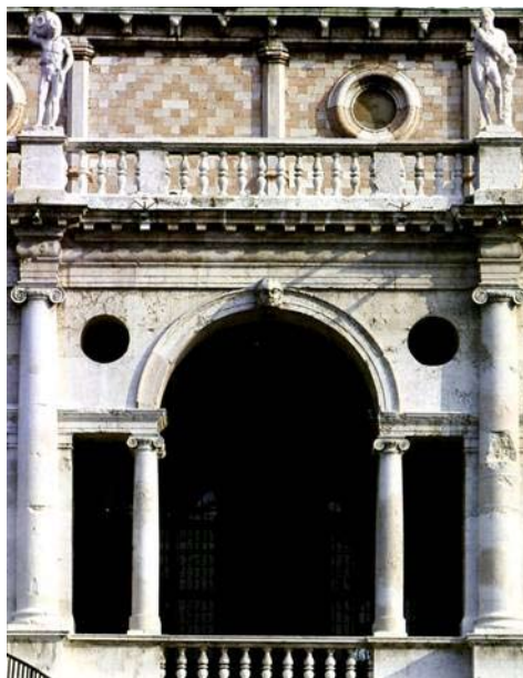
Рис. 8. Палладиёво окно. Деталь юго-восточного фасада Палаццо делла Раджионе (Базилики) в Виченце. Проект А. Палладио. 1549. Источник: Romanelli G. Palladio. – Milano: Giunti Editore, 1995. – P. 3
