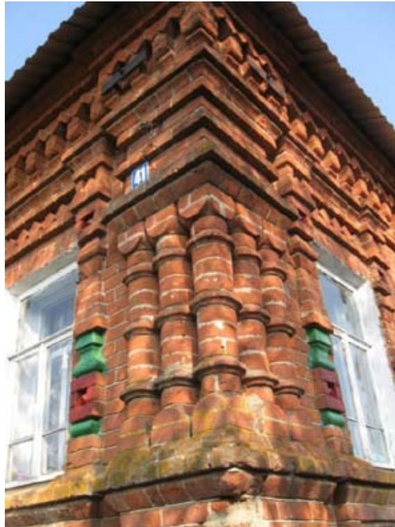
Рис. 5. Фрагмент стены жилого дома Галанова в с. Богородское на ул. Советской, 41. Главный западный и боковой южный фасады идентичны по композиции и составу декоративных форм традиционной русской архитектуры. Оба фасада фланкированы боковыми огибающими лопатками. Каждая лопатка состоит из трех полуколонн, завершающихся кубоватыми капителями, которые примыкают к обрамлениям оконных проемов. Стойки оконных наличников включают точеные полуколонны, кубышки, вставки граненых камней. Навершия наличников содержат ряд ромбов. Трехчастные фартуки наличников обработаны уходящими в глубину уступами. Простой по профилировке карниз опирается на бегунец, образуя мотив крепостных бойниц.
