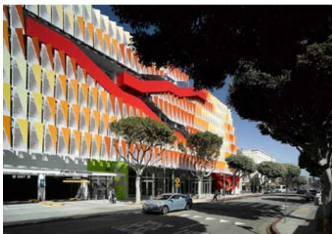
Рис 2. Многоэтажный паркинг в Санта Монике, США. Источник: http://www.ongreening.com/en/Projects/santa-monica-parking-structure-6-1089
