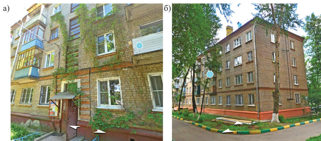
Рис. 1. Существующий кирпичный 5-этажный жилой дом (серия 1-447): а – фрагмент подъезда с балконами; б – общий вид дома
