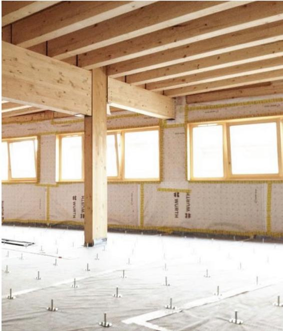
Рис. 4. Несущие элементы стоечно-балочной системы, и щитовая конструкция наружных стен здания Wolokura (г. Монрёй, Франция) арх. Graam architecture Источник: <https://graamarchitecture.fr/WOLOKURA>
