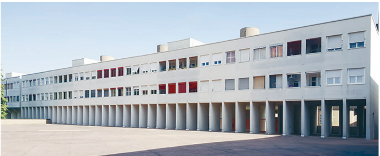
Рис. 2. Жилой дом Gallaratese, Милан, Италия (1967–1974). Источник: Carlo Aymonino, Aldo Rossi. Gallaratese Monte Amiata Complex. Milan. Italy 1967-1974 [Электронный ресурс]. – A+t architecture publishers, 2017. – URL: https://aplust.net/blog/carlo_aymonino_aldo_rossi_gallaratese_monte_amiata_complex_milan_italy/ свободно
