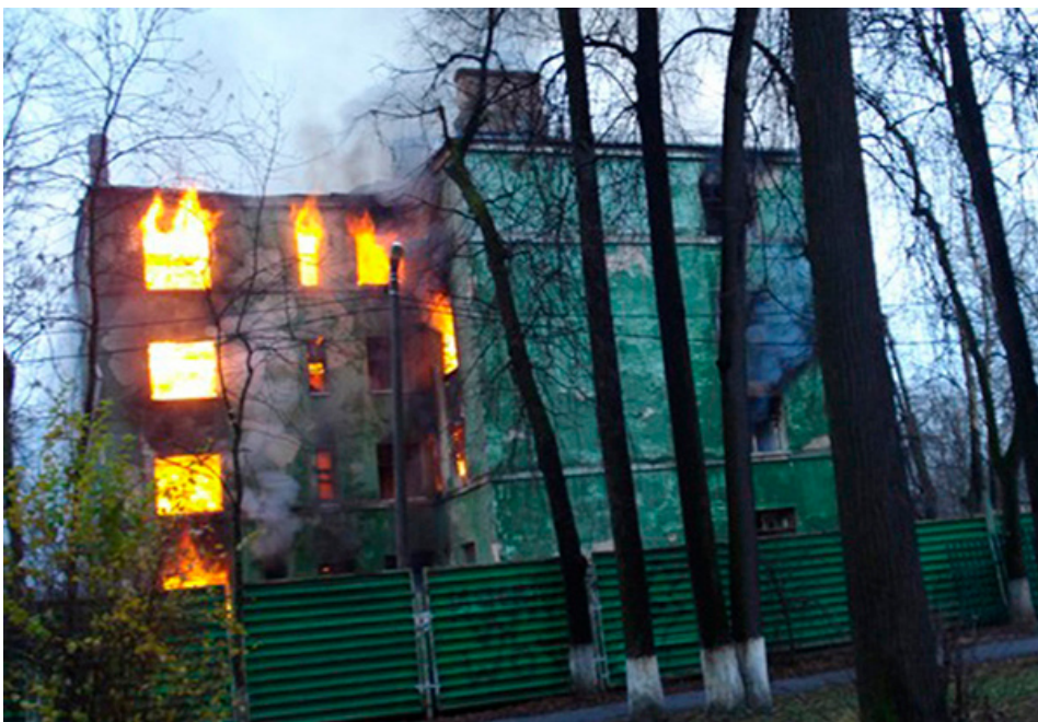
Рис.1. Дом «Стройбюро» во время пожара в 2013 г.
