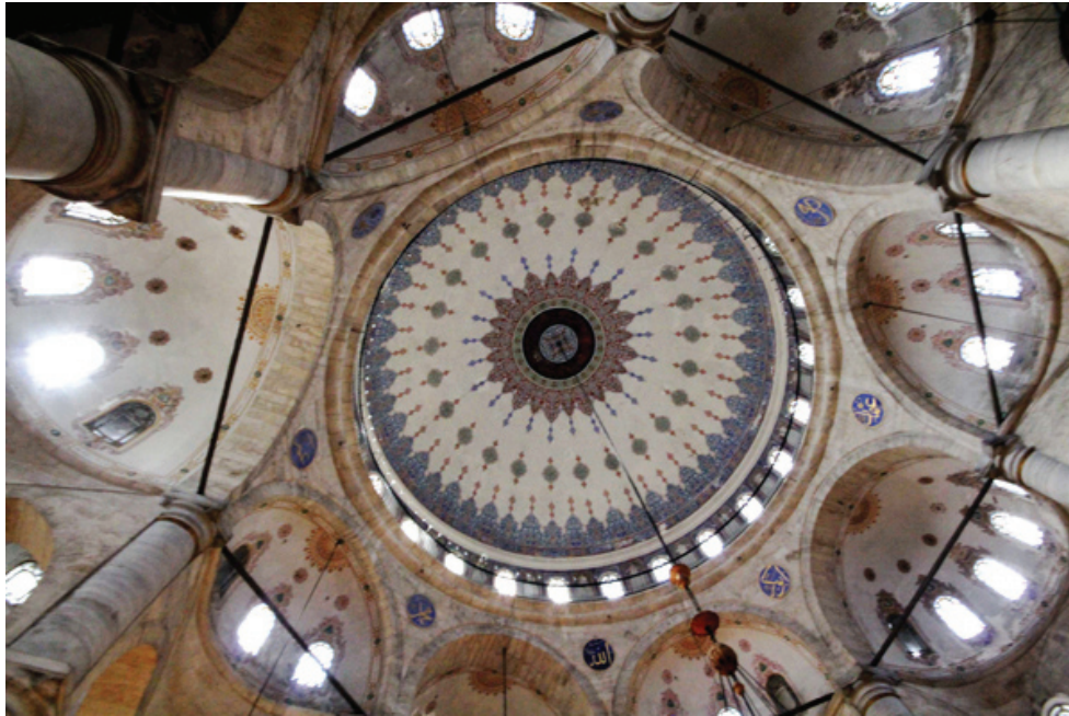
Рис. 9. Мечеть Эйюп. Перекрытия (фото Е. Кононенко, 2018)
