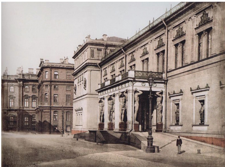
Рис.15. Здание Нового Эрмитажа в Санкт-Петербурге. Южный фасад. 1842–1851. Проект Лео фон Кленце. Фототипия 1897 г. Из архива В. Г. Власова
