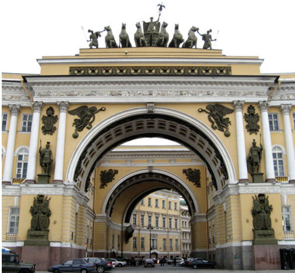
Рис. 18. Арка здания Главного штаба в Санкт-Петербурге. 1819–1829. Арх. К. И. Росси. Фото В. Г. Власова, 2012
