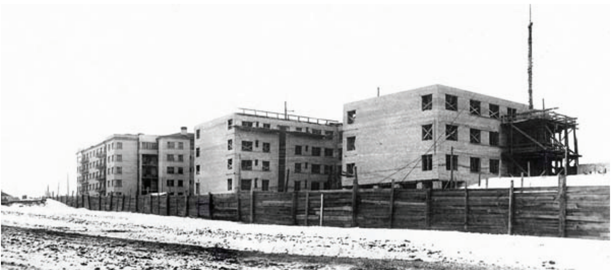
Рис. 3. Жилой дом «Гигант № 2» в процессе строительства. ГАРО. Фотоотдел. ПА – 799)
