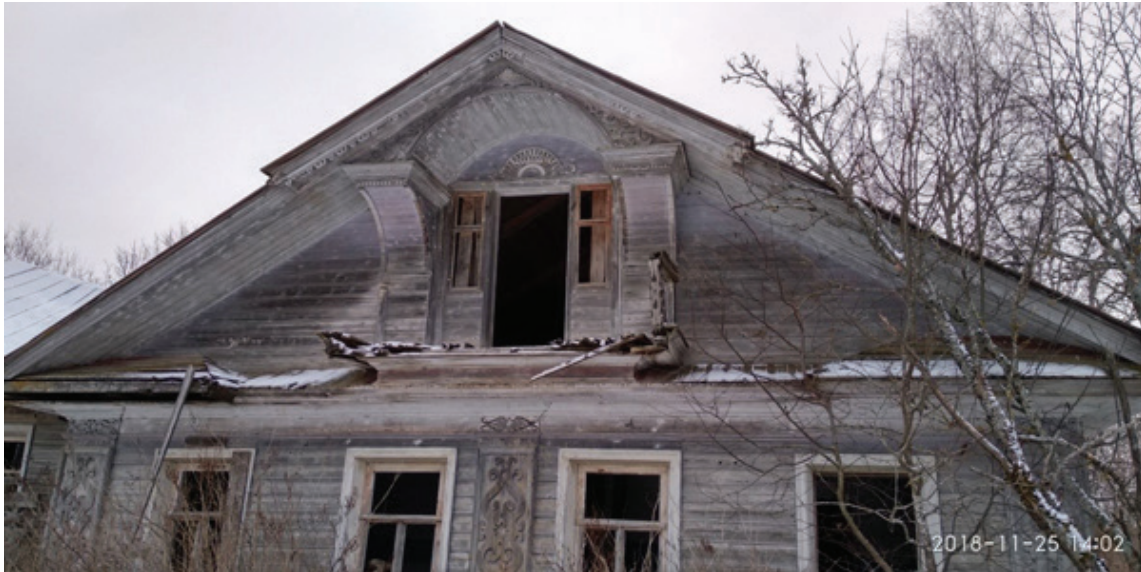
Рис. 6. Жилой флигель. Портик мансардного этажа с балконной дверью. Современное состояние. Фото И. Белоярской
