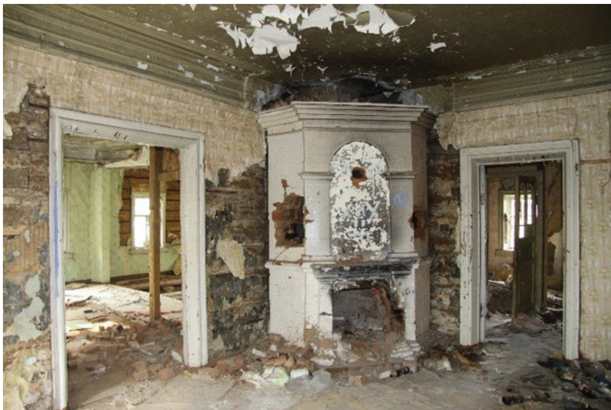
Рис. 3. Первый этаж. Интерьер кабинета. Камин, облицованный кафелем. Современное состояние. Фото И. Белоярской
