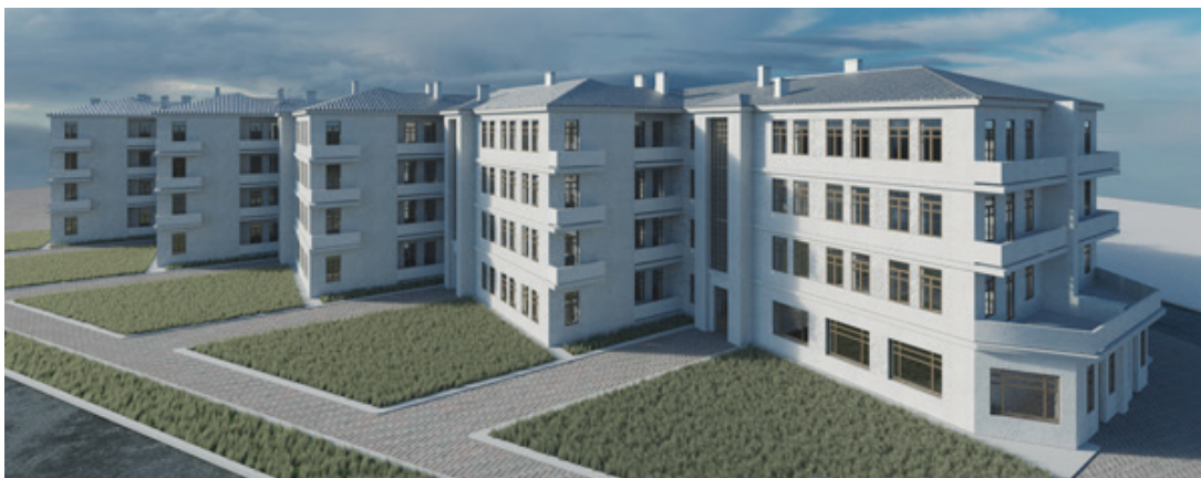
Рис. 2. Жилой дом «Гармошка». Арх. Н. В. Троицкий. Построен в 1930 г. Стилистика конструктивизма. Визуализация А.С. Танкеева, А.Э. Заплавной
