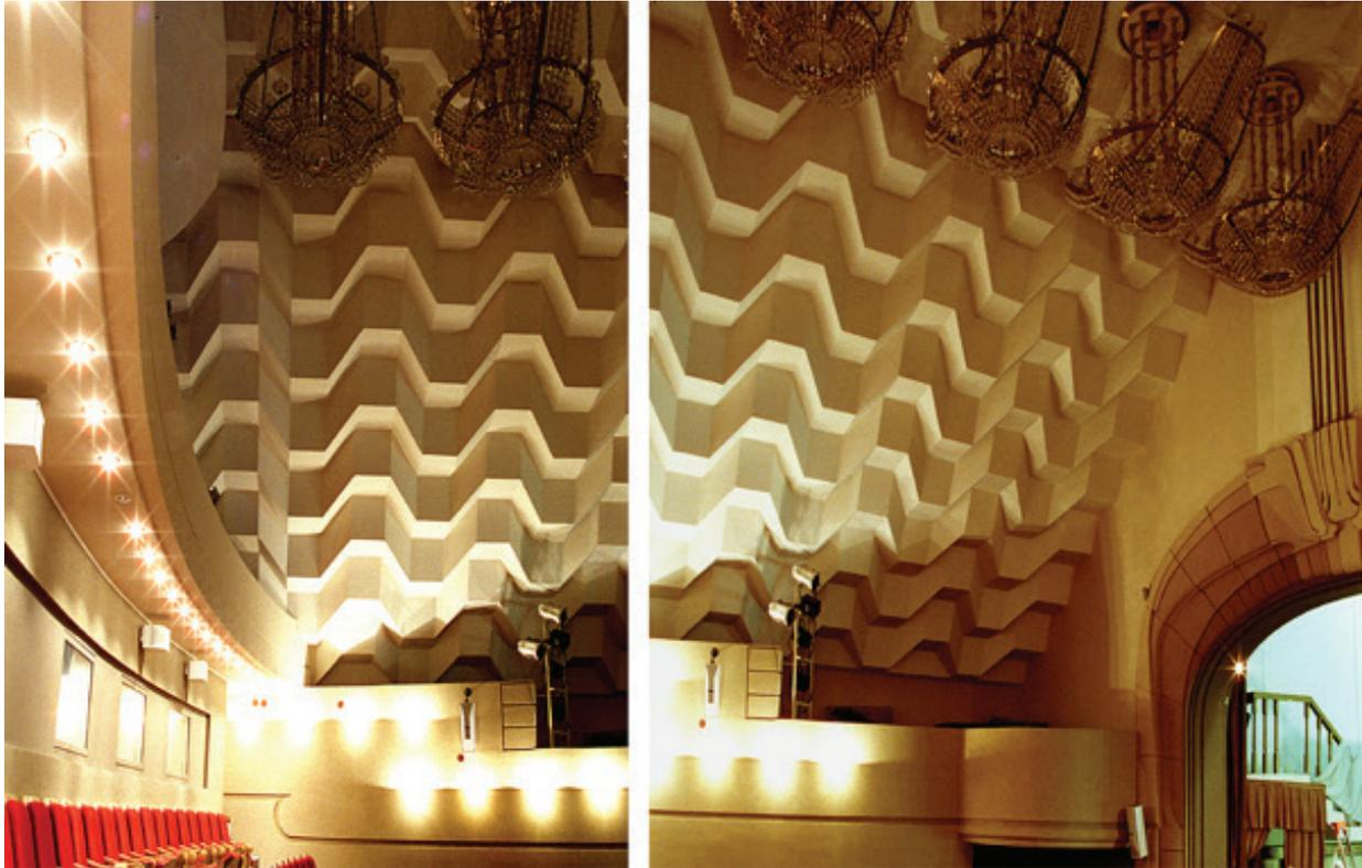
Рис.15. Складчатый акустический потолок концертного зала Камерного театра в Екатеринбурге. Автор рельефа потолка и фото А.В. Коротич
