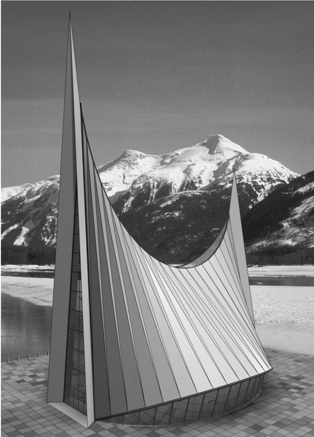
Рис.12. Покрытие общественного здания, форма которого образована путем складчатой аппроксимации цилиндриода. Автор концепта и рисунка А.В. Коротич
