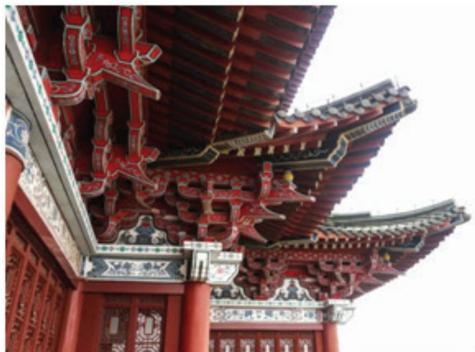
Рис. 13. Гун – переход между колонной и крышей крупных зданий. Источник: Ли Шивэнь. Деревянная пагода Инсянь. – Пекин: Строительная промышленность Китая, 2015
