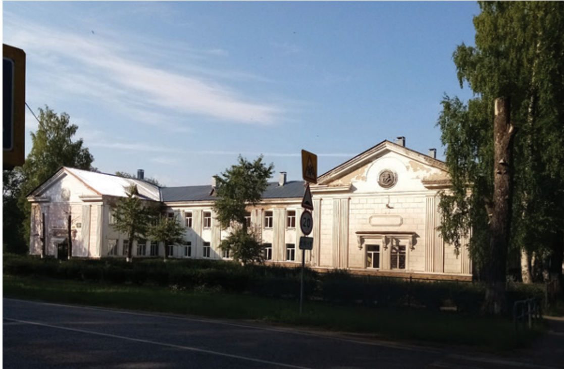
Рис. 4. Здание школы (ул. Коммунистическая, 1). Фото И.В. Зыкина
