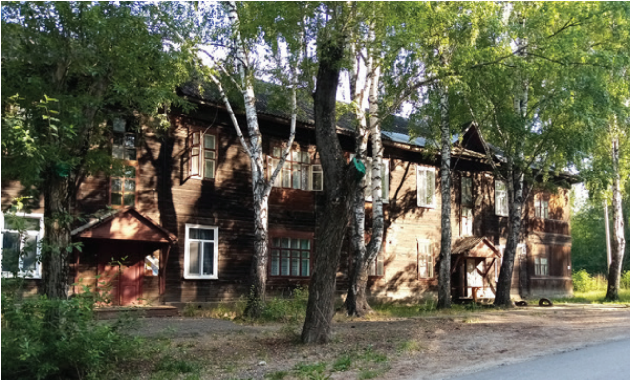
Рис. 2. 8-квартирный жилой дом на ул. Большевистская, 14. Фото И.В. Зыкина
