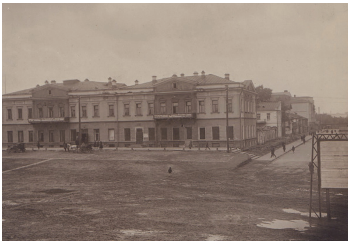
Рис.1. Вид на здание бывшего Сибирского торгового банка в Свердловске, угол ул. Ленина и Володарского Ф. 3. оп. 1. ед. хр. 19/14-6
