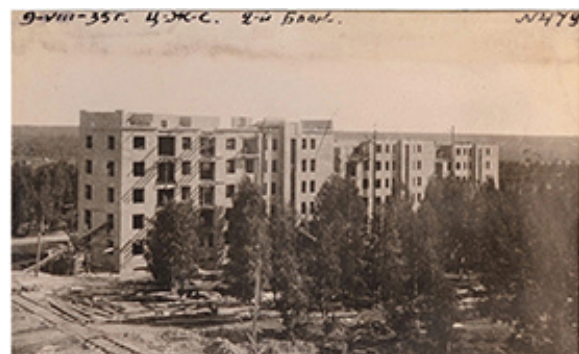
Рис. 9.4. Вид с юго-запада на ЦЖС-4. (2-й Блок, ул. Каменская, 9). Фото И.Г. Озорнина, 1935. Музей ОАО УАЗ-СУАЛ. Фотореставрация Е.П. Топаловой. 2017
