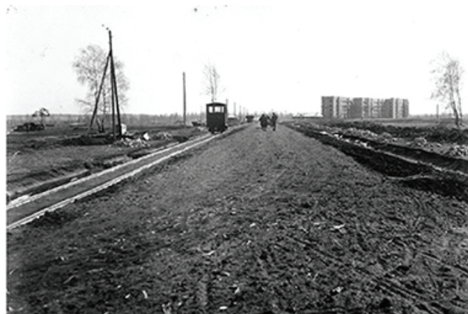
Рис. 6.2. Дорога на УАЗ. Вид с северо-запада на ЦЖС-1. (1-й Блок, ул. Алюминиевая, 12). Фото И.Г. Озорнина конца марта 1935. Музей ОАО УАЗ-СУАЛ
