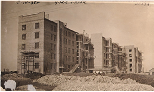
Рис. 9.5. Вид с юго-востока на ЦЖС-1. (1-й блок, Алюминиевая, 12). Фото И.Г. Озорнина, 1935. Музей ОАО УАЗ-СУАЛ. Фотореставрация Е.П. Топаловой. 2017
