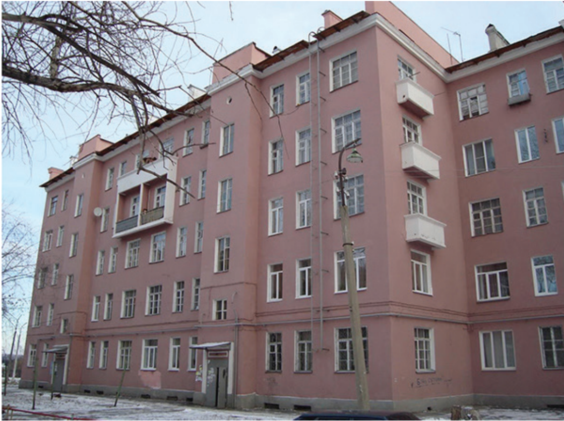
Рис. 12.2. Вид с юго-запада на ЦЖС-3 (4-й Блок, ул. Исетская, 11). Фото Т.А. Коротовских, 2009. Частный архив С.И. Гавриловой
