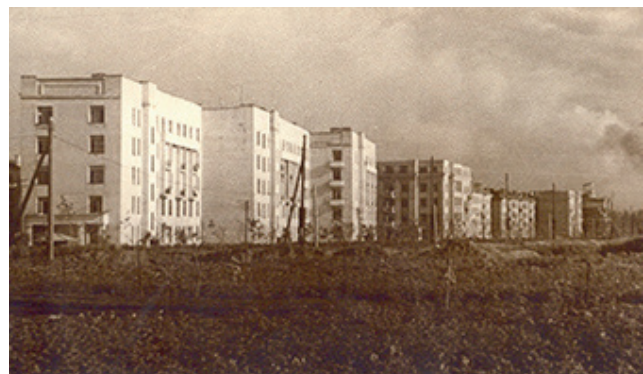
Рис. 9.2. Вид с северо-запада на ЦЖС-1. (1-й блок, Алюминиевая, 12) после реконструкции фасадов, 1940-е. Архив КУКМ. Фонд «Уралалюминстрой»
