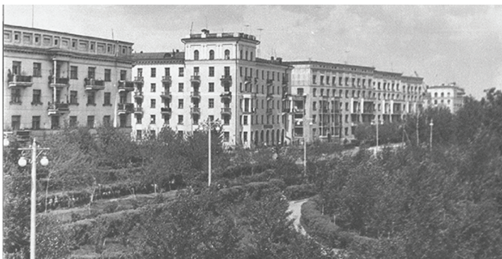
Рис. 15.2. Вид с юго-востока на комплекс ЦЖС. Фото 1950-х гг. Архив КУКМ. Фонд «Уралалюминстрой»
