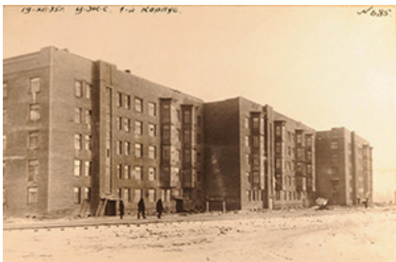
Рис. 9.1. Вид с северо-запада на ЦЖС-1. (1-й блок, Алюминиевая, 12), 1935. Музей ОАО УАЗ-СУАЛ. Фотореставрация Е.П. Топаловой. 2017
