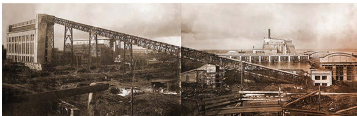
Рис. 1. Эстакада подачи щепы в варочный цех. 1939 г. [7, с.140–141]
