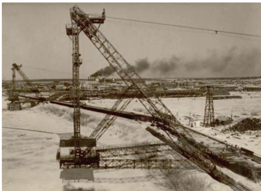
Рис. 4. Кабель-краны на лесной бирже Соликамского сульфитно-целлюлозного завода. Фото 1940-х гг. Источник: https://www.solbum.ru/news/novosti/kray-trudovoy-doblesti/
