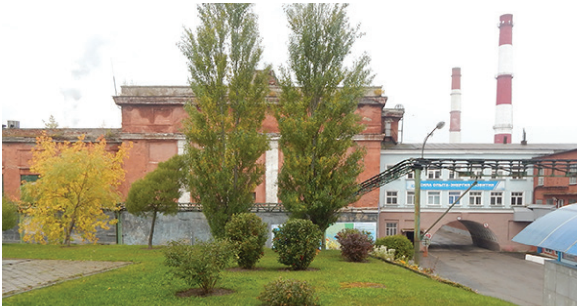
Рис. 6. Бывшие отбельный, сушильный, отжимной и бумажный цеха Соликамского сульфитно-целлюлозного завода и арка (справа), соединявшая их с варочно-кислотным цехом. Состояние до демонтажных работ. Фотоархив отдела по связям с общественностью АО «Соликамскбумпром»
