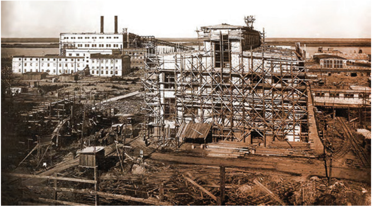
Рис. 2. Теплоэлектроцентр и очистной цех Архангельского целлюлозно-бумажного комбината. Июль 1939 г. [7, с. 136–137]
