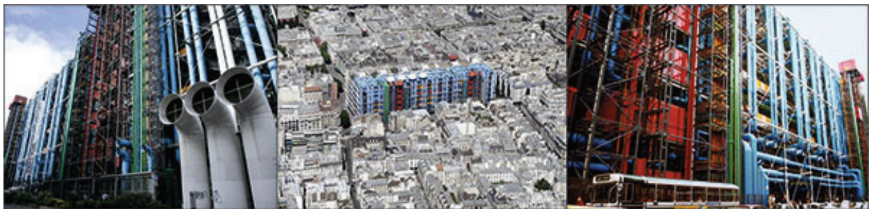
Рис.11. Центр Помпиду в Париже. Сост. А.Р. Бочкарева
