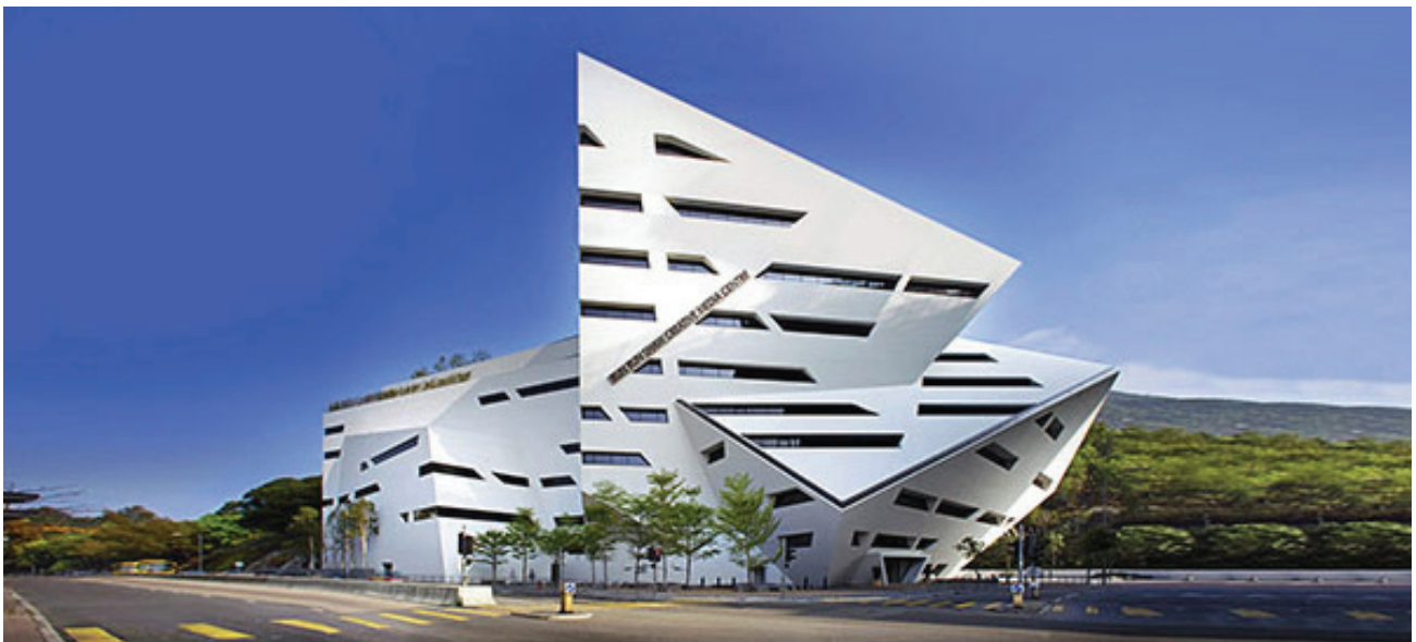
Рис. 5. Творческий медиацентр RunRunShaw. Кампус Гонконгского университета. Источник: https://www.leighorange.com/wp-content/uploads/2017/09/03006_City-U-Media-Building_01-2000x946.jpg
