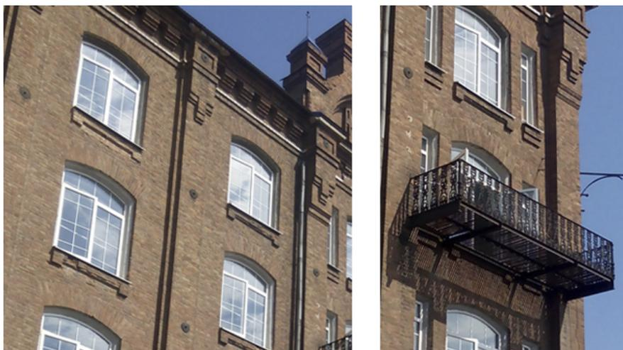
Рис.1. Конструктивные крепежные элементы в виде металлических клепок и балкон, полностью выполненный из металла паровой мельницы купца Юрова в Оренбурге. Фото С.Г. Шлеюк
