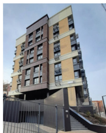
Рис. 4. Клубный дом «Бартон хаус». Первый этаж отведен под клубные функции. Видны автомобильные ворота в цокольном этаже. Фото авторов
