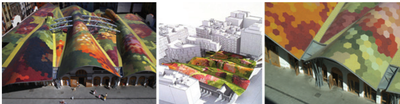
Рис. 6. Рынок Santa Caterina в Барселоне. Испания. 2004. Арх. Энрике Миралес и Бенедетта Тальябуе (EMBT Arquitectes). Источник: https://en.wikiarquitectura.com/building/santa-catarina-market/
