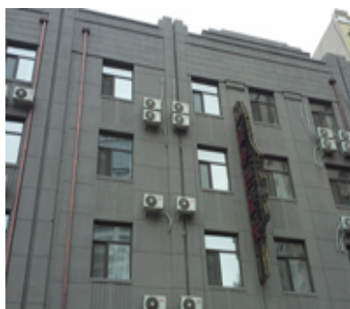
б – фрагмент фасада гостиницы, расчлененного пилястрами
