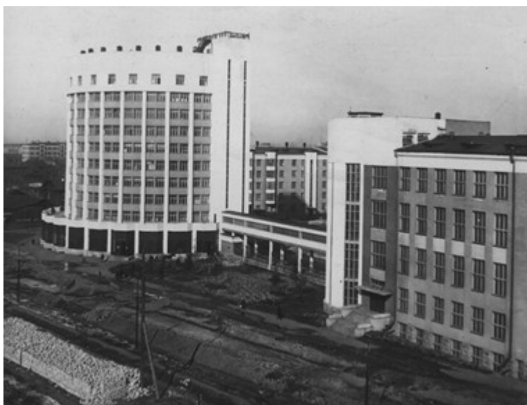
Рис. 3. Жилкомбинат НКВД: дом гостиничного типа «Динамо» и Дом культуры им. Дзержинского, связанные наземным переходом, 1932. Источник: https://nashural.ru/mesta/sverdlovskaya-oblast/ekaterinburg/podzemelye-gorodka-chekestov/
